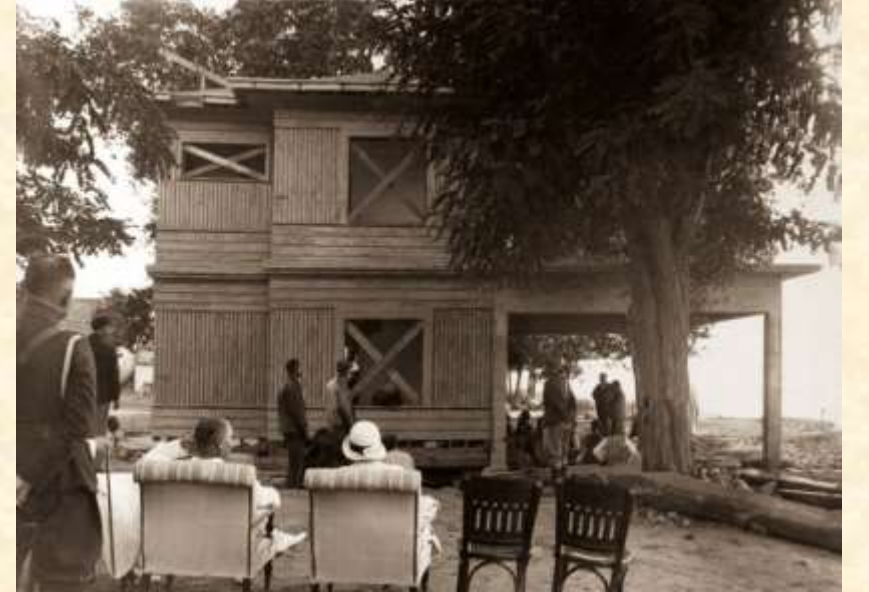
Yürüyen Köşk inşaatını izlerken (Yalova, 8 Ağustos 1930)
