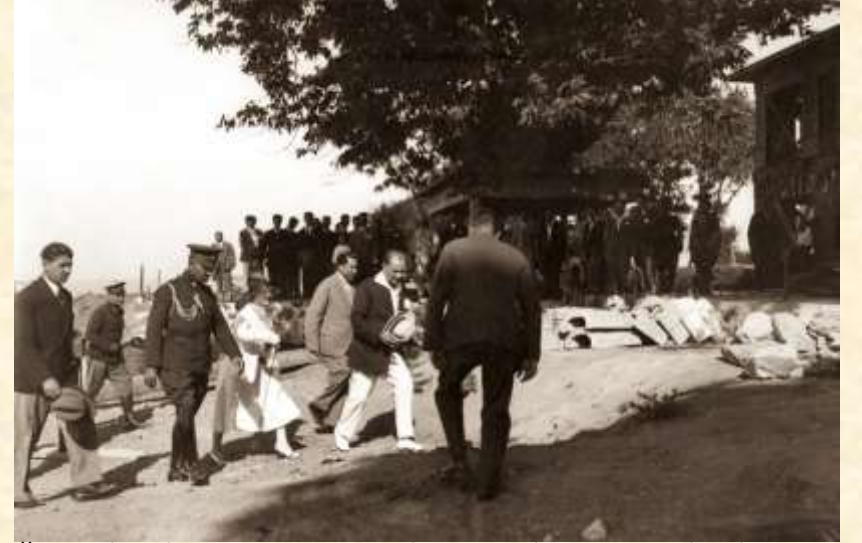
Bir ağacın kesilmemesi için raylı sistemle taşınan köşkün inşaatı, (Yalova, 8 Ağustos 1930)
